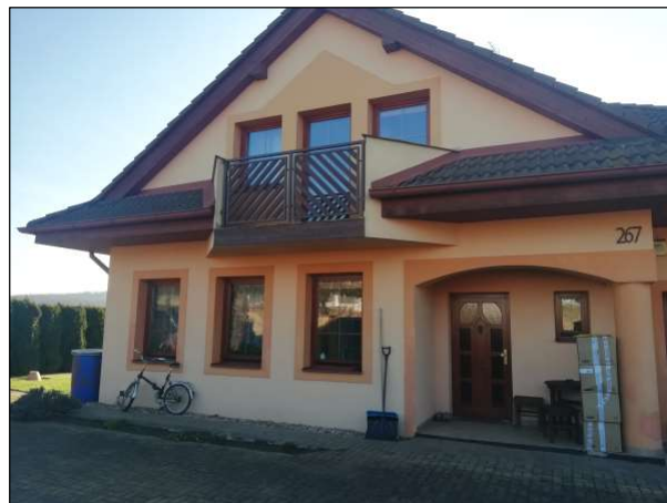
Bod 2 – umístění mikrofonu (balkon)
