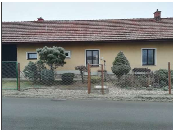
Bod 3 – měřený objekt, Krňany 23
