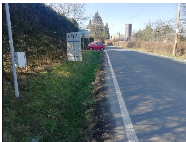
Měřený profil silnice II/104, sm. Petrov, Davle
